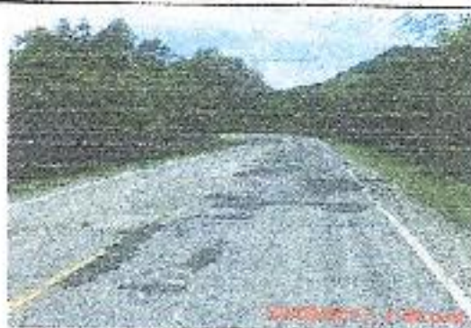
FOTO 04 RUTA: 8001 SECCION: P-22143D OBSERVACIONES: VARIOS BACHOS (TRAMO 2)
