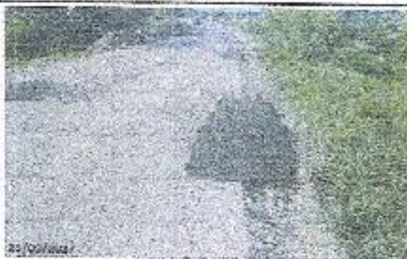
FOTO 05 RUTA: 8000 SECCION: P-12143D OBSERVACIONES: VARIOS BACHOS (TRAMO 2)
