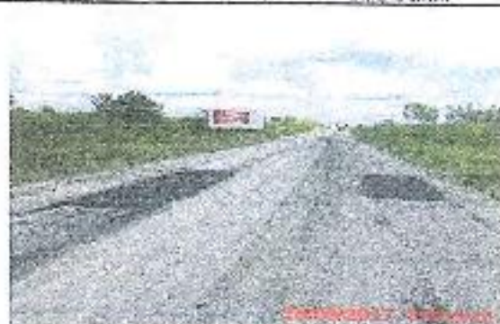
FOTO 02 RUTA 0002 SECTOR: PR 20-0700 y PR 04-707 OBSERVACIONES: VARIOS BACHES TRAZADO
