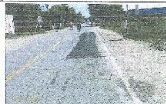
FOTO 06 RUTA 0002 SECTOR: PR 04-707 OBSERVACIONES: VARIOS BACHES TRAZADO
