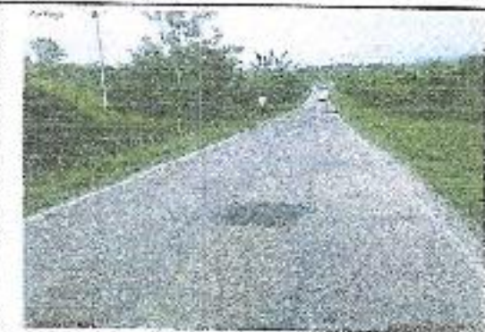
FOTO 13 RUTA: 8301 SECTOR: PR 13460 OBSERVACIONES: VAMOS SACRISTRANOS 5
