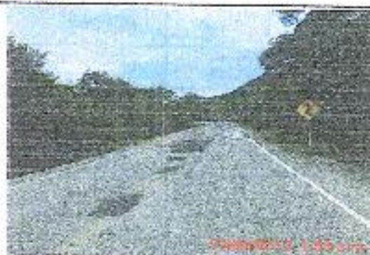
FOTO 08 RUTA: 8000 SECCION: P-12143D OBSERVACIONES: VARIOS BACHOS (TRAMO 2)
