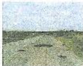
FOTO 04 RUTA 0002 SECTOR: PR 02-0300 y PR 04-707 OBSERVACIONES: VARIOS BACHES TRAZADO
