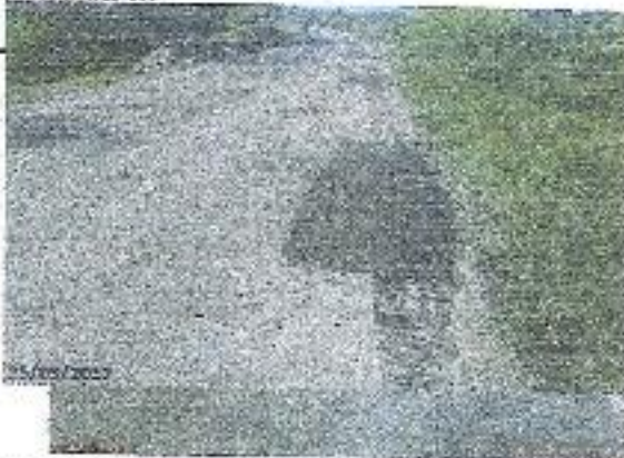
FOTO 11 RUTA: 8301 SECTOR: PR 13462 OBSERVACIONES: VAMOS SACRISTRANOS 5
