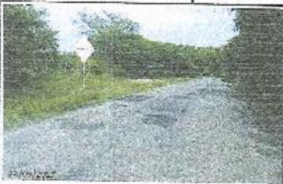
FOTO 08 RUTA: 8342 SECTOR: PR 834-830 OBSERVACIONES: VAMOS SACRISTRANOS 5
