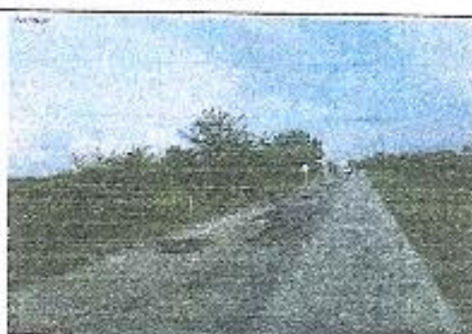
FOTO 14 RUTA: 8301 SECTOR: PR 13450 OBSERVACIONES: VAMOS SACRISTRANOS 5
